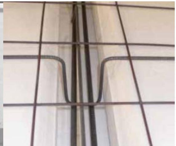
Los estribos de acero Ø6 mm se colocan en las viguetas del forjado antes de verter el hormigón a una distancia de 150 cm el uno del otro y sostienen las barras de refuerzo inferiores separándolas del fondo del panel y asegurando la cobertura de hormigón mínima sobre la armadura.
