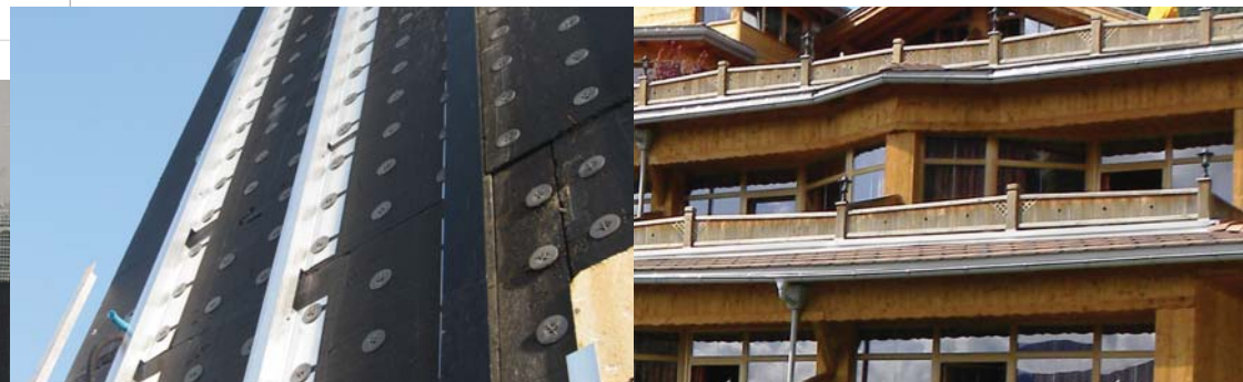
Revestimiento en seco, fijado mecánicamente
