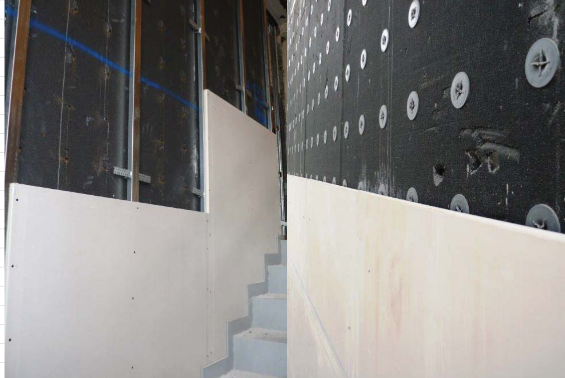
Cartón yeso montado en una estructura
