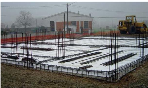
**Modelo S:** Los paneles se producen solo en EPS no auto portantes y colocados como capa de aeración y aislamiento en la planta baja para garantizar una ventilación natural y un aislamiento sin puentes térmicos.
