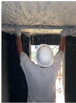
**Modelo I:** en este modelo, los paneles están recubiertos al intradós de malla metálica, la cual tiene la función de garantizar la adherencia para la colocación del yeso.
