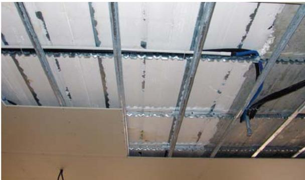
**Modelo C.:** para el acabado en seco con los perfiles metálicos expuestos a una distancia entre ejes de 30 cm - los paneles no llevan ninguna malla metálica ya que están destinados a dejarse sin pulir o cubiertos con placas de cartón yeso, cielo falso o cualquier tipo de acabado en seco.
