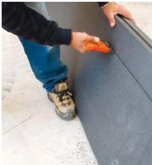
3 Corte del panel en correspondencia del perfil metálico
